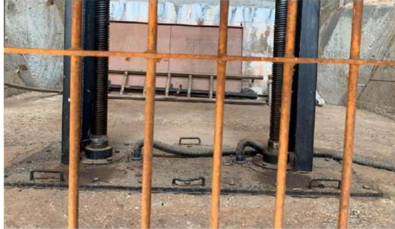
Foto 3 - Mostra a comporta do descarregador de fundo.
