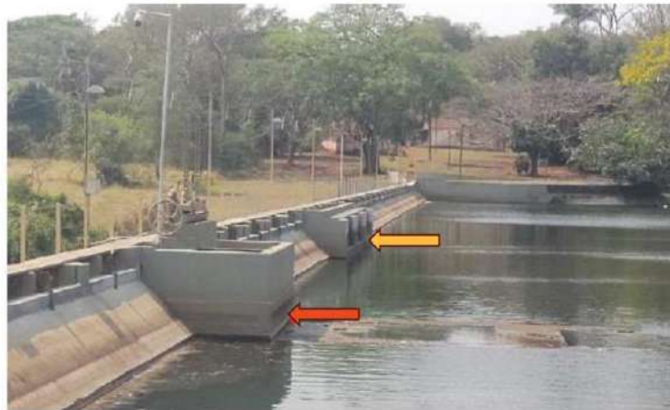
Foto 8– Estrutura da tomada d'água (seta laranja) e vertedouro (seta amarela).
