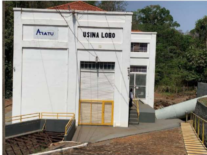
Foto 13 – Casa de Força da Usina Lobo.
