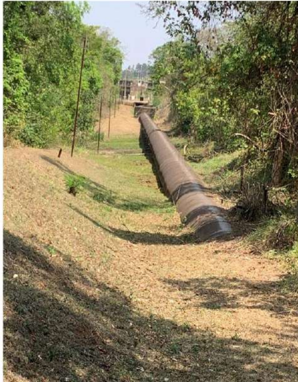
Foto 11 – Parte do conduto encoberto e parte exposto.
