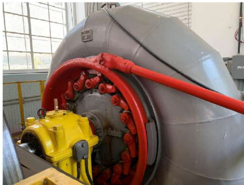
Foto 14 – Turbina do tipo Francis Horizontal.
