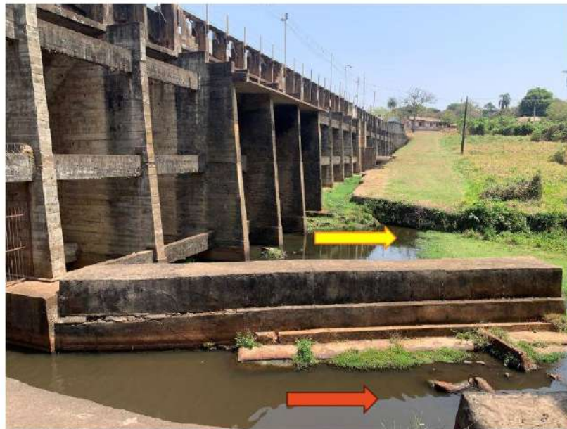
Foto 4 - Canal e dissipação do descarregador de fundo (seta laranja) e do vertedouro principal (seta amarela).
