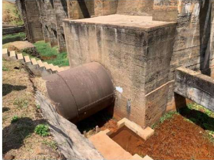
Foto 10 – Mostra o engastamento do Conduto Adutor na estrutura da Tomada d' Água.
