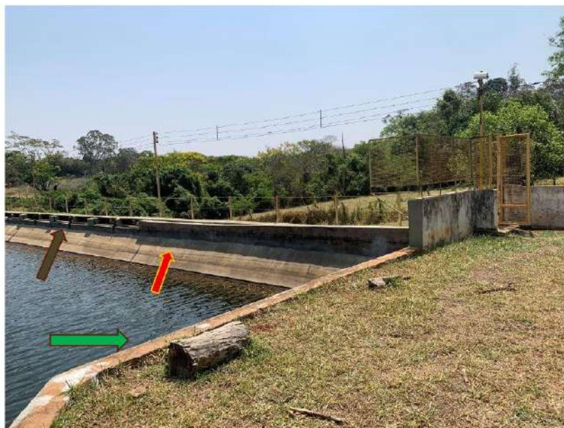
Foto 2 - Mostra a barragem por montante (seta vermelha), ombreira direita (seta verde) e os vãos de vertedouro de soleira livre (seta cinza).
